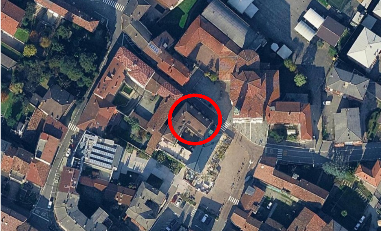
Figura 1 - Inquadramento geografico dell'edificio
