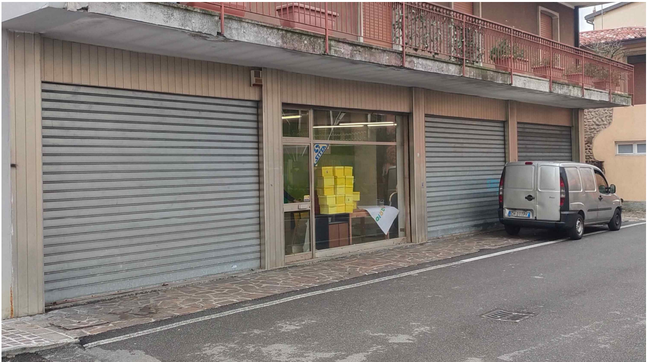
Figura 02 – Vista dettagliata delle vetrine su strada con le serrande metalliche e la vetrata che include la porta d’ingresso al negozio
