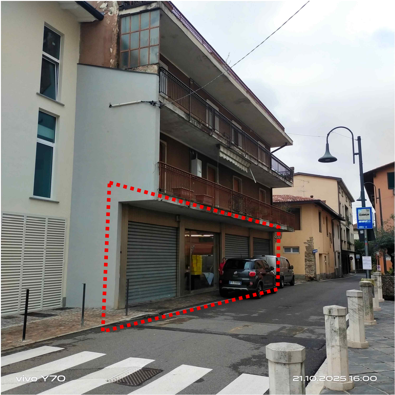
Figura 01 – Vista del fronte nord-est della palazzina con al piano terra le vetrine su strada con la porta d’ingresso del negozio
