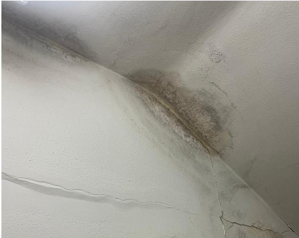
*Figura 27 – Alterazioni cromatiche nel sottoscala*
