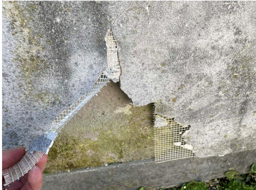
*Figura 23 – Distacco dell'intonaco*
