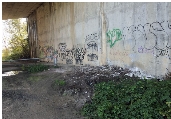
Il sottopasso ripulito dai rifiuti, rimossi su disposizione degli uffici comunali (foto del 30 ottobre 2024)
